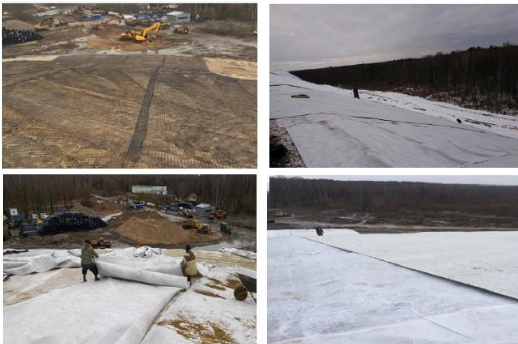
Рис. 2. Монтаж геосинтетичних матеріалів
